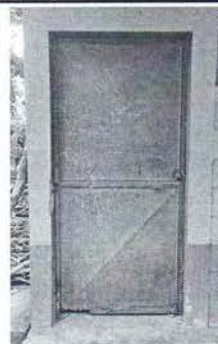
Foto 6: Se observa que las puertas del modulo de aulas 1 se encuentran muy deterioradas y es necesario su sustitución.
