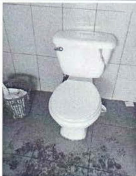
Foto 1: Se observa que los inododos estan rotos y presentan fugas. Deben ser cambiados
