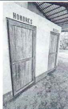
Foto 2: Se observa que las puertas de los baños son de madera, ya no cierran y estan en mal estado, por lo que se busca cambiarlas por unas de metal.
