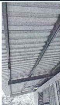
Foto 5: Se observa que estructura de soporte ya se inicia a oxidar y es necesario que se le de mantenimiento.
