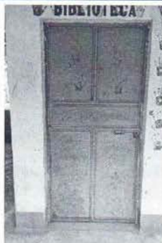
Foto 7: Se observa que las puertas del modulo de aulas 2 del primer y segundo nivel, se encuentran en mal estado y se les debe dar mantenimiento.
