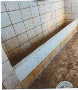
Foto 7: Se amplió el mingitorio se arreglo tubería de pvc
