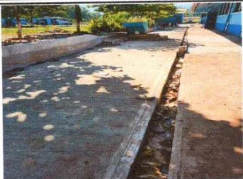
Foto13: Reparación de planchas de concreto en patio.
