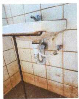
Foto 6: Se realizo el cambio de accesorios en los lavamanos.
