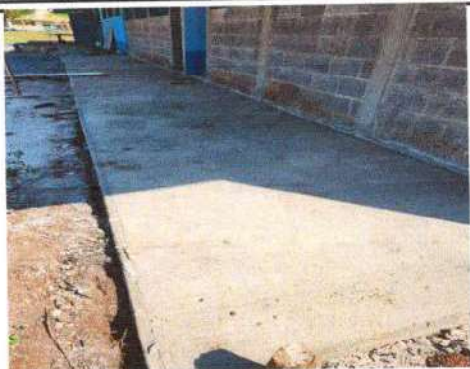
Foto 19: Suministro de banquetta de concreto en módulo 5
