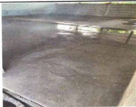
Foto 18: Suministro de piso concreto en módulo 5
