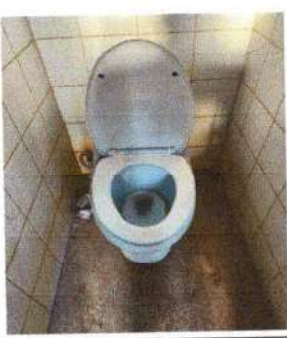
Foto 5: Se realizo el cambio de accesorios en los sanitarios.
