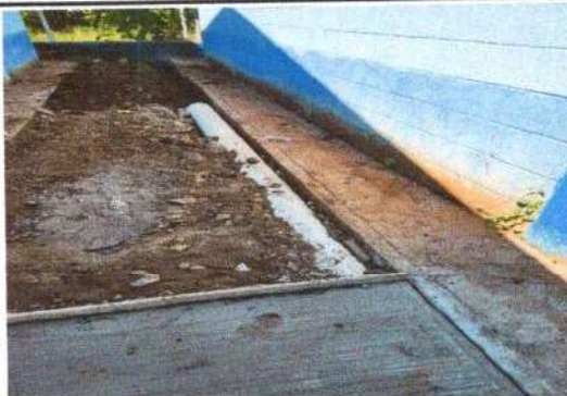
Foto 14: Suministro de tubería de pvc aguas pluviales.
