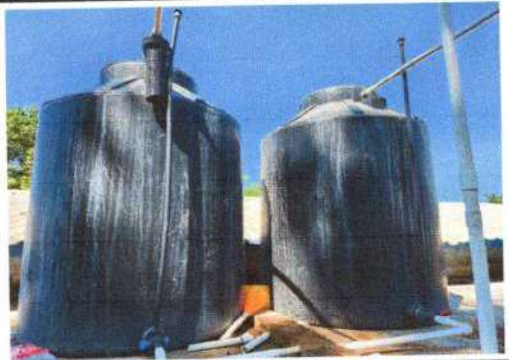
Foto 4: Tubería de rotoplas y accesorios reparados.
