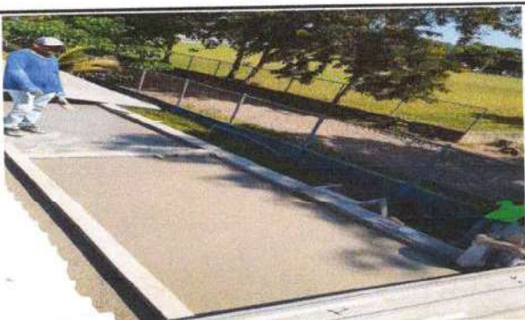
Foto 3: Terraza totalmente reparada.
