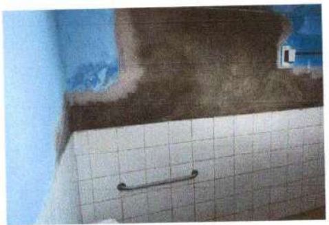
Foto 2: Las paredes de los sanitarios repelladas.
