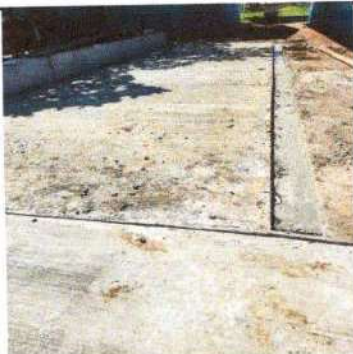
Foto 11: Suministro de cuneta para agua pluvial.
