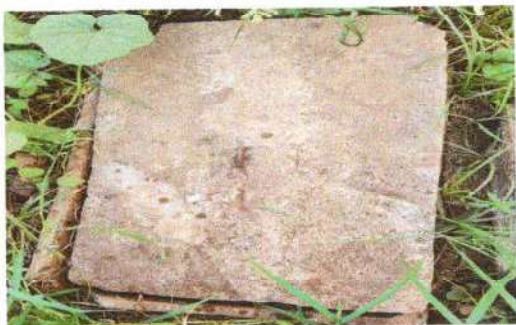
Foto 15: Se instalaron tapaderas a las cajas de agua pluvial.
