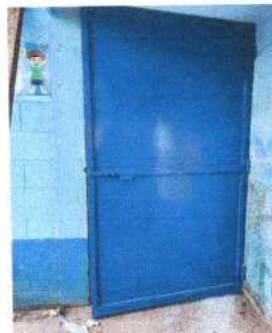
Foto 20: Se cambio la puerta de los baños.
