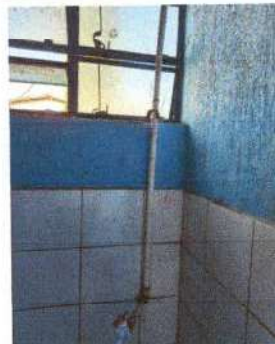
Foto 16: Se realizo limpieza y cambio de tubería de pvc.
