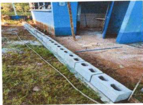
Foto 9: Suministro de bordillo de block en baños.
