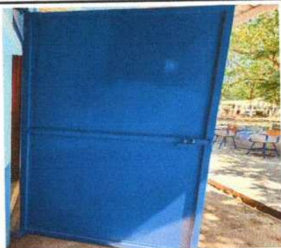
Foto 21: Reparación de veinte puertas.
