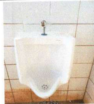
Foto 10: Colocación de urinal nuevo.
