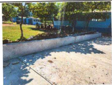
Foto 12: Suministro de bordillo de block con repello.
