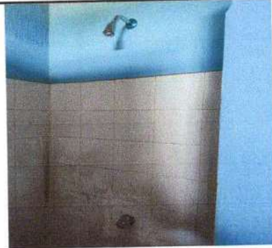
Foto 8: Colocación de llaves de duchas.
