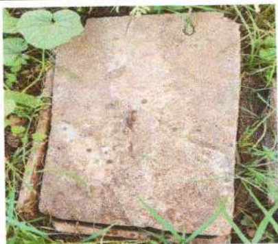
Foto 15: Suministro de tapaderas a cajas de agua pluvial
