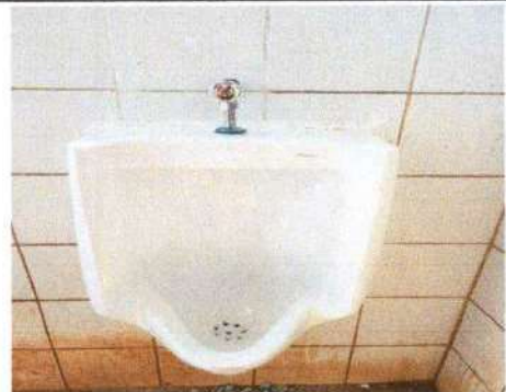
Foto 10: instalando el urinal nuevo.
