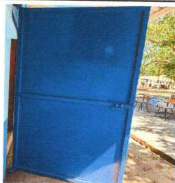
Foto 21: Reparación de puertas en proceso, lijado y pintura.
