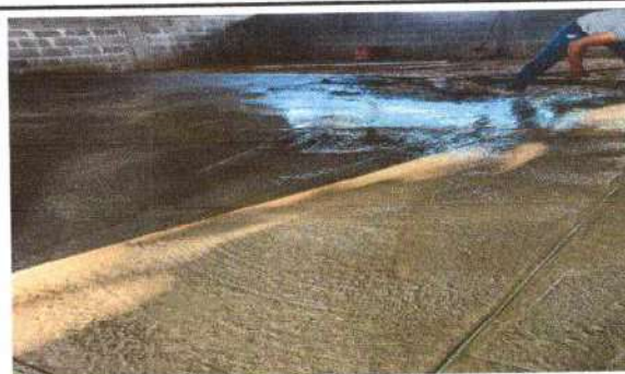
Foto 18: Se observa la aplicación de concreto para el piso.
