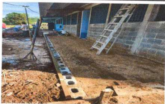
Foto 19: Banqueta en proceso, nivelación y relleno.
