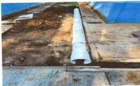
Foto 14: Instalando la tubería para el agua pluvial.
