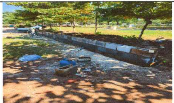
Foto 12: Suministro de bordillo.
