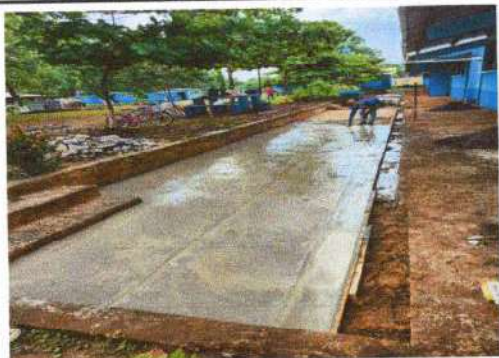
Foto13: Proceso de las tortas de cemento en patio.
