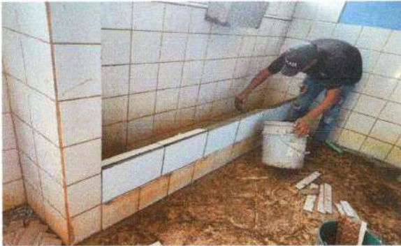
Foto7: Proceso de reparación del mingitorio con azulejo.
