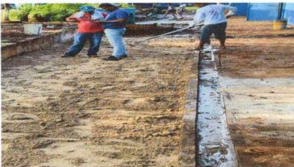
Foto 11: Proceso del suministro de cuneta para aguas pluviales.
