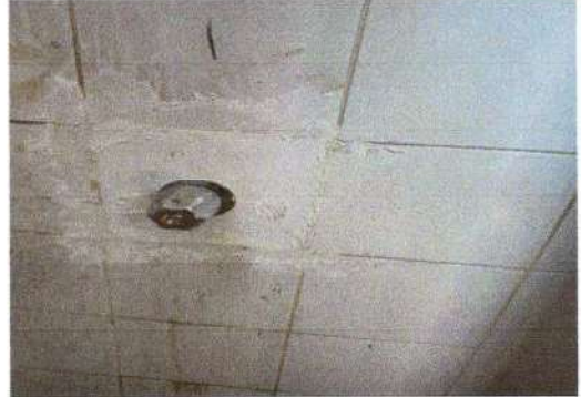
Foto 8: Reparación de llave de ducha.
