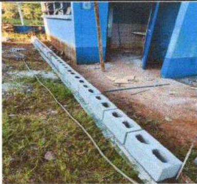
Foto 9: Suministro de bordillo de block en baños.
