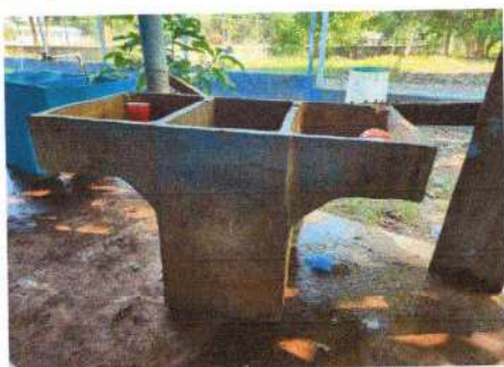
Foto 17: Se quitaron las pilas deterioradas.
