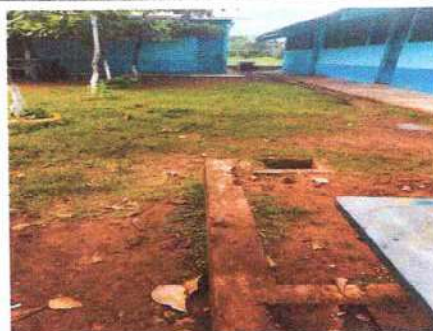
Foto 12: Suministro de bordillo.
