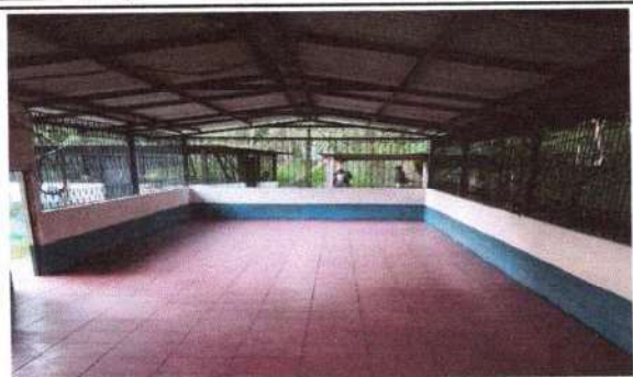
Foto 1: Piso cerámico totalmente instalado
