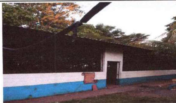
Foto 4: Balcones totalmente instalados
