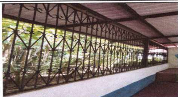
Foto 5: Balcones totalmente instalados
