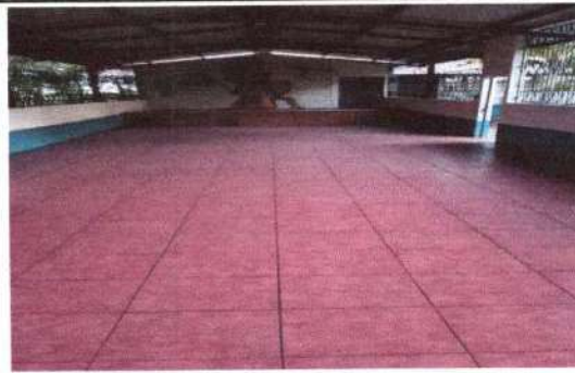
Foto 2: Piso cerámico totalmente instalado
