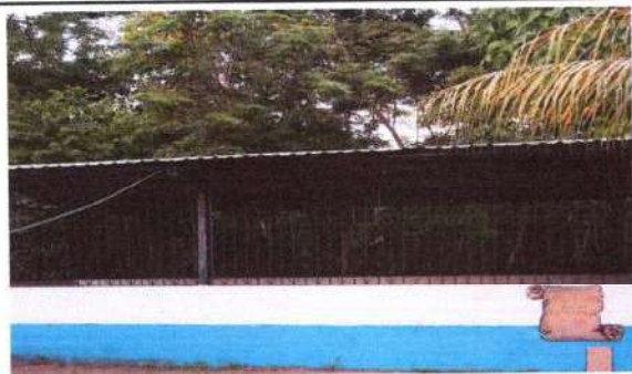
Foto 3: Balcones totalmente instalados
