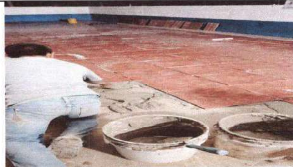
Foto 4: Aplicación de pegamix para la instalación del piso cerámico
