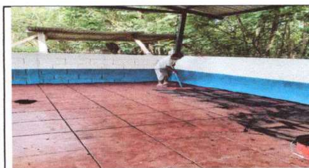
Foto 6: Aplicación de la sisa en el piso cerámico
