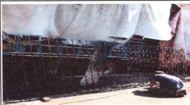
Foto 2: Elaborando los Balcones de Metal
