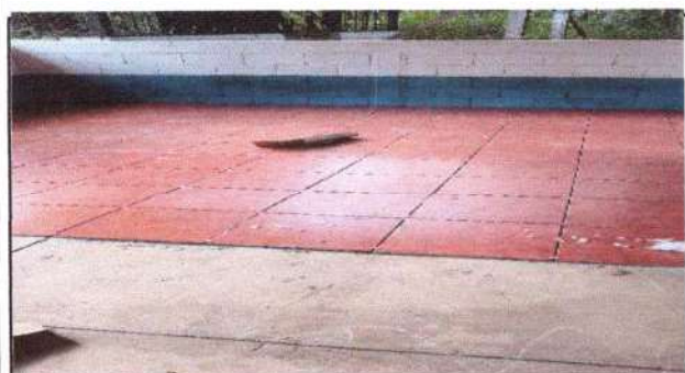
Foto 5: Instalando el Piso Cerámico
