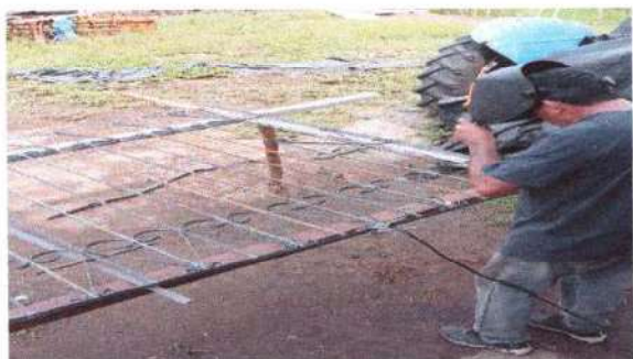
Foto 1: Elaboración de los Balcones de Metal
