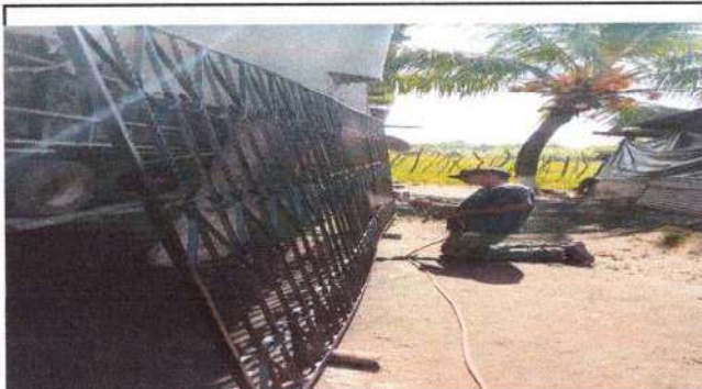
Foto 3: Pintando los Balcones de Metal
