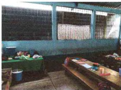
Foto 13: Se Observan las paredes que se les aplicará pintura.
