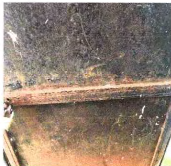
Foto 7: Se Observan las puertas a las que se sustituirán por estar en mal estado
