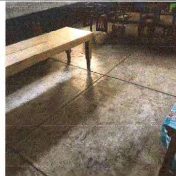
Foto 10: Se Observa el piso al que se le colocará piso cerámico.
