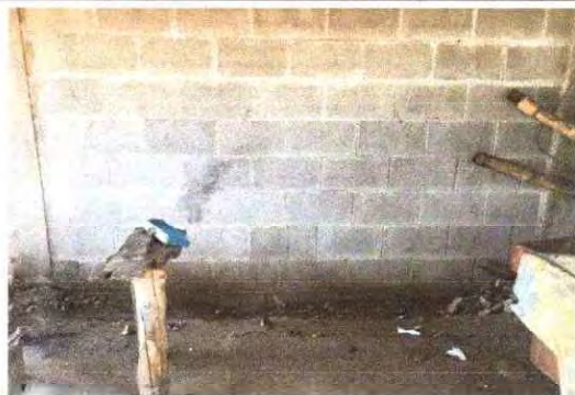
Foto 9: Se Observan las paredes a las que se les aplicará el repello
