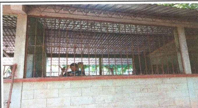
FOTO 2: Se observa el proceso de colocación de balcones.
