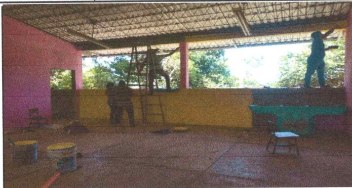
FOTO 1: Se observa el proceso de pintado en las paredes de los salones de clases interior y exterior.
