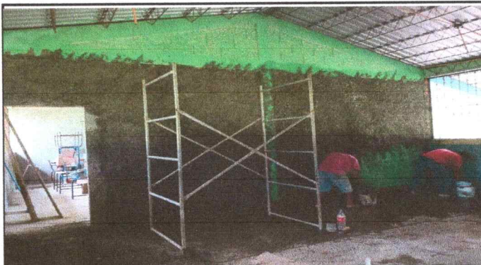
FOTO 4: Se observa el proceso de repello en las paredes de los salones de clases
