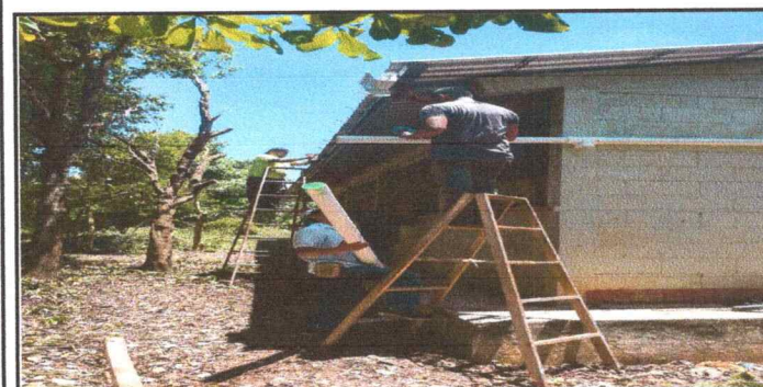
FOTO 5: Se obser el proceso de colocación de canal para la bajada de agua.
