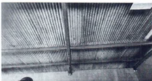
Foto 1: Se observa el módulo de la cocina que necesita, conformación de muro mas mojinete, instalación de estructura portante de metal e instalación de lámina troquelada.
