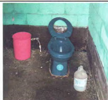
Foto 6: Se hace evidente el mal estado de los inodores, algunos presentan serios daños o incluso pérdida del depósito de agua, por lo que es necesario sustituirlos.
