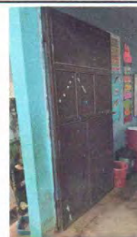
Foto 12: La puerta evidencia daños en su estructura general, a pesar de recibir mantenimiento previo no se ha podido mejorar la situación, por lo cual es necesario sustituirla.
