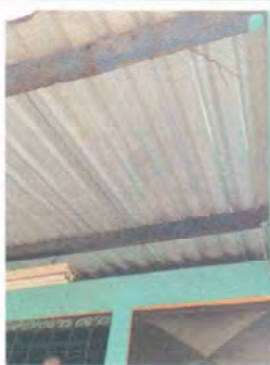
Foto 11: La estructura de soporte de uno de los módulos de aulas está muy deteriorada, se evidencia un alto nivel de óxido y desgaste, por lo cual es necesario sustituirla.
