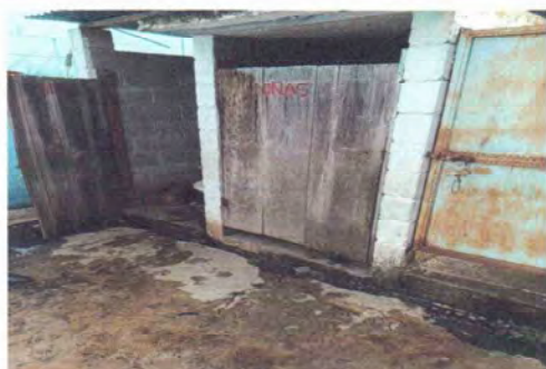
Foto 5: Actualmente 2 de las puertas de los servicios sanitarios son de madera, están deterioradas completamente, por lo que es necesario sustituirlas.
