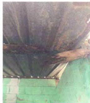
Foto 2: Se evidencia el mal estado de la estructura de madera de los sanitarios, por lo que es necesario sustituirla por estructura de metal.
