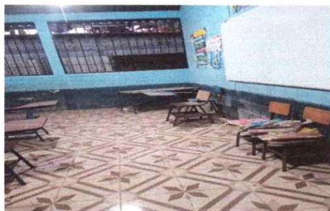
Foto 1: se observa el piso ceramico ya terminado.
