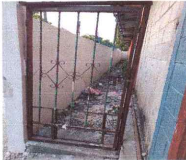
Foto 9: se observa el repello del muro perimetral terminado.
