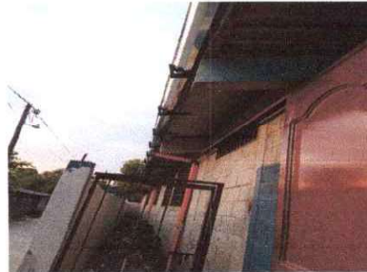
Foto 10: se observa de canales terminado.
