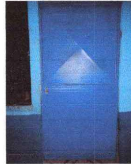
Foto 8: observacion de chapa ya terminada.
