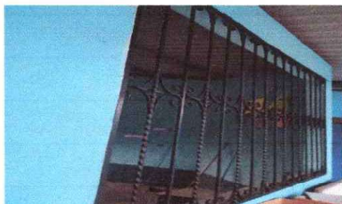
Foto 3: se observa el mantenimiento de los balcones ya terminado.
