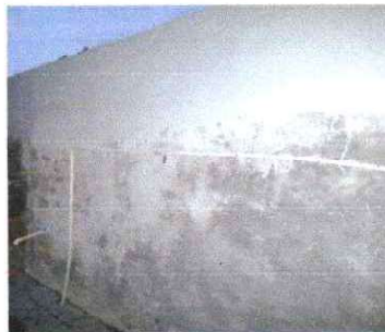
Foto 11: se observacion de aplicación de savieta del muro perimetral que se ubica en el area de cocina terminado.
