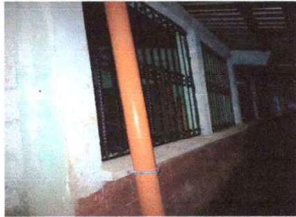
Foto 7: se observa el mantenimiento a los balcones ya terminado.
