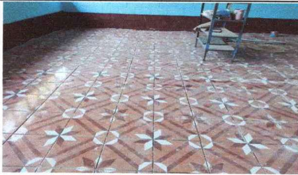
Foto 1: Se observa que se ha finalizado con el piso cerámico dentro de todos los módulos.
