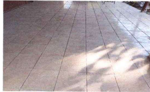
Foto 2: Se observa que sen el modulo 2 que se terminó de colocar el piso cerámico
