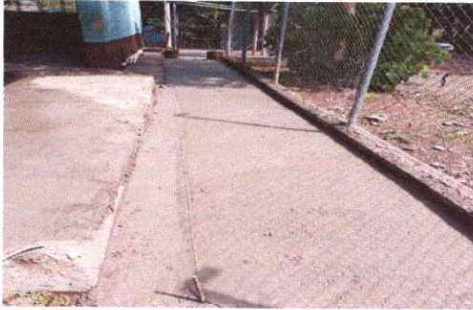
Foto 1: Se observa que el modulo 1 el pasillo se encuentra finalizada la obra.
