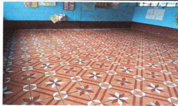
Foto 1: Se observa otro aángulo de como quedó el piso cerámico
