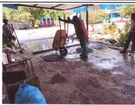
Foto 2: Se observa que sen el modulo 2 que estaán colocando la torta de cemento.
