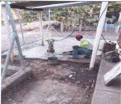
Foto 1: Se observa que el modulo 1 el pasillo se encuentra en mejores condiciones.
