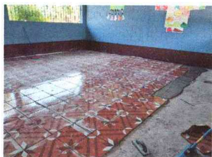
Foto 1: Se observa que están casi culminando con los primeros módulos.
