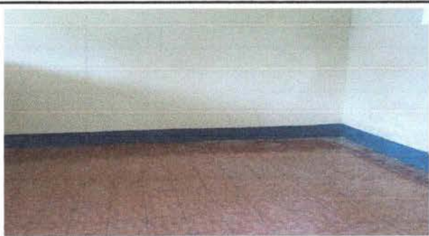
Foto 1: Se observa instalación completa de piso cerámico.
