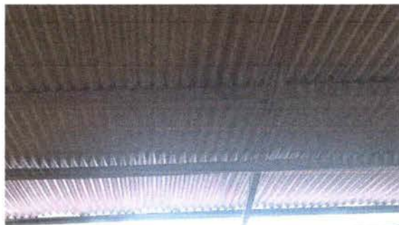
Foto 10: Se observa el cambio total de la estructura de soporte metálica.
