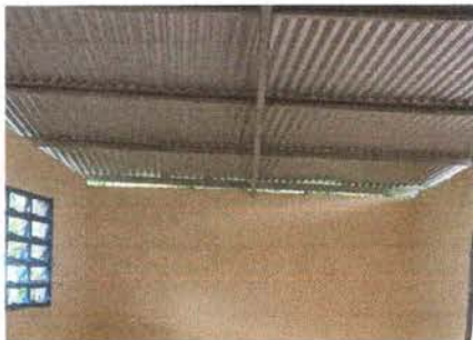
Foto 3: Se observa la el cambio total de la estructura de techo.
