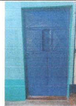
Foto 2: Se observa la estructura de puerta ya con su respectivo mantenimiento.
