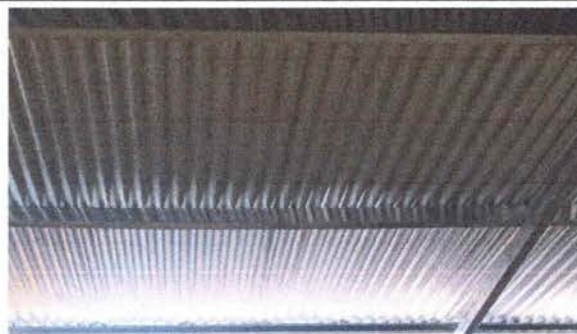
Foto 10: Se observa el cambio total de lámina metálica.
