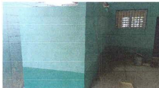
Foto 8: Se observa los muros de los baños terminados.
