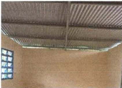
Foto 3: Se observa la el cambio total de la estructura de techo.
