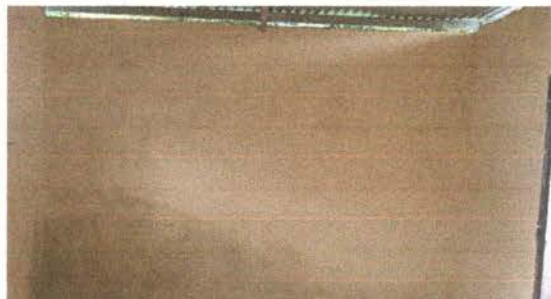
Foto 7: Se observa el repello terminado en las paredes.
