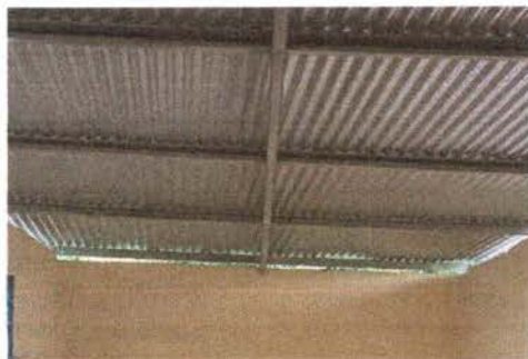
Foto 4: Se observa el cambio total de lámina metálica.
