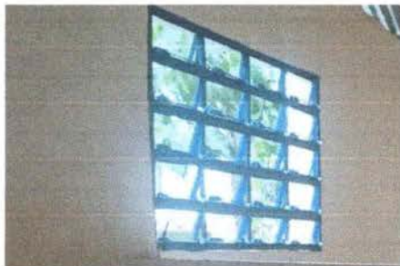
Foto 5: Se observa la sustitución del ventanal.
