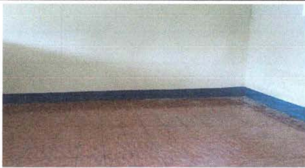
Foto 1: Se observa instalación completa de piso cerámico.
