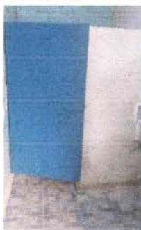
Foto 9: Se observa las puertas de los baños ya instaladas.
