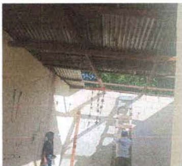
Foto 3: Se observa el desmonte de la estructura de techo.
