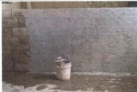
Foto 7: Se observa las paredes en repello.
