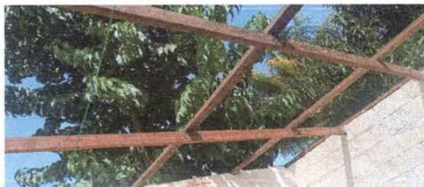
Foto 4: Se observa el desmonte de la estructura metálica de techo.
