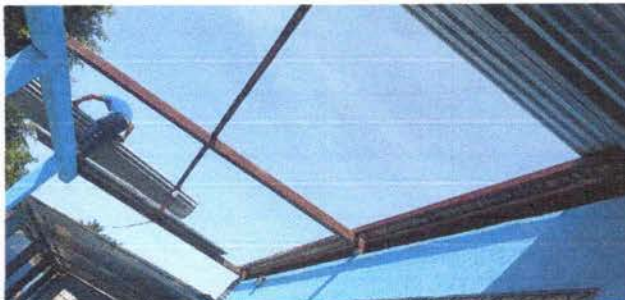
Foto 10: Se observa el desmonte de la lámina metálica.
