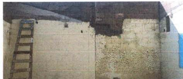
Foto 6: Se observa el reforzamiento de la pared.
