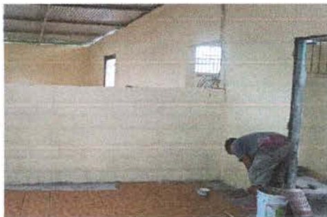
Foto 1: Se observa que la instalación de piso cerámico.
