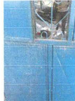
Foto 2: Se observa el desmonte de la puerta para su mantenimiento.
