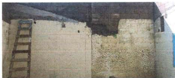
Foto 6: Se observa el reforzamiento de la pared.
