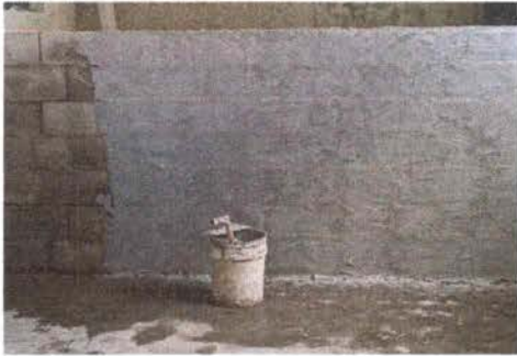
Foto 7: Se observa las paredes en repello.
