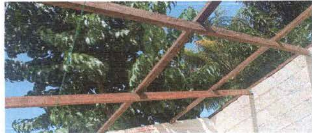
Foto 4: Se observa el desmonte de la estructura metálica de techo.
