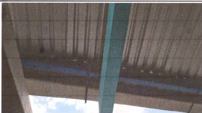
Foto 9: Se observa la mejora en la estructura de soporte de metal
