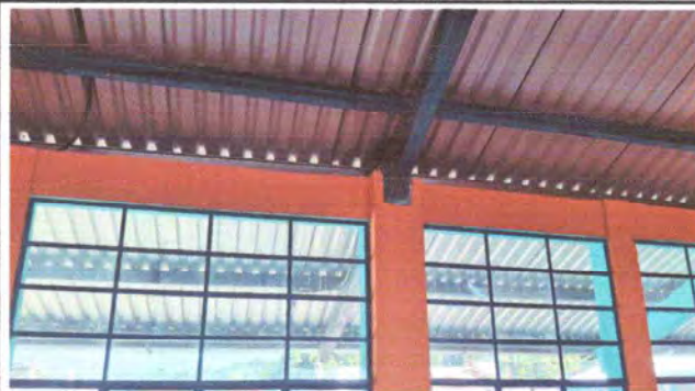
Foto 4: Se observa la mejora con la colocación de costanera entre la pared y la solera
