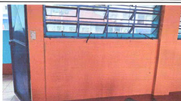
Foto 2: Se observa la mejora de la pintura en muros
