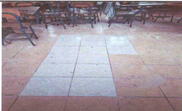
Foto 1: Se observa la mejora del piso cerámico
