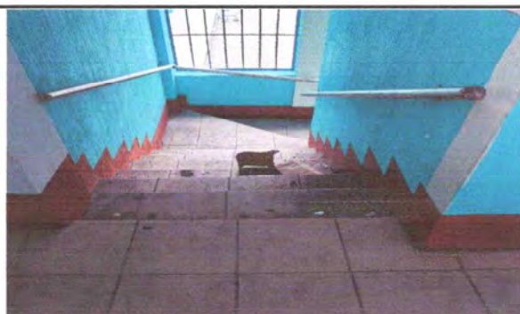
Foto 5: Se observa la mejora con la puesta de pasamanos en las gradas
