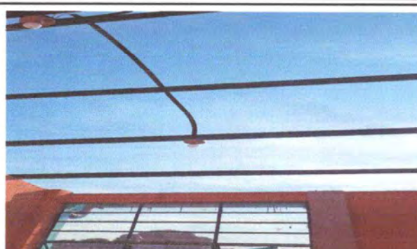
Foto 8: Se observa el avance del cambio de la lamina
