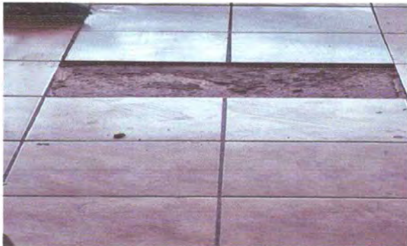
Foto 1: Se observa el avance de la mejora del piso cerámico
