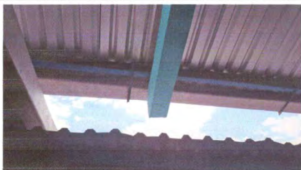
Foto 9. Se observa el avance del mantenimiento a la estructura de soporte de metal
