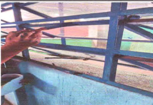
Foto 3: Se observa el avance de la pintura en los balcones.
