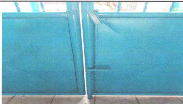
Foto 7: Se observa el avance de la pintura del porton de entrada principal.
