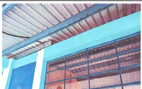
Foto 4: Se observa el avance de la colocación de costanera entre la pared y la solera.
