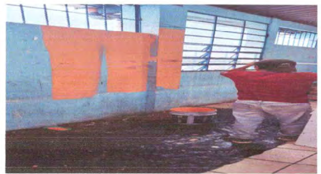
Foto 2: Se observa el avance de la pintura en muros
