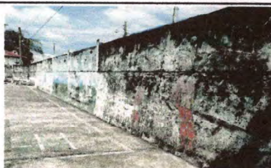
Foto 6: Se observa el mal estado de la pintura en el muro perimetral
