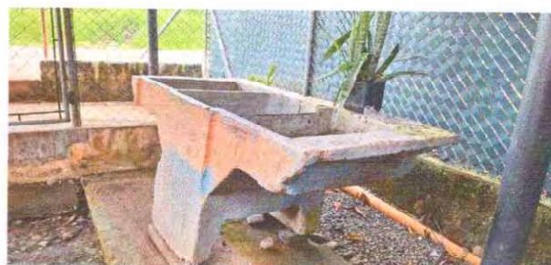
Foto 6: Se observa que es necesario el cambio de pila por deterioro.
