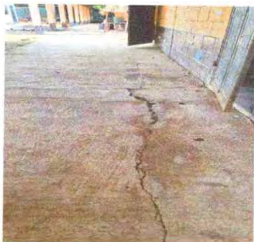
Foto 13: Se observa que es necesario reparar torta de concreto en respectivos pasillos.
