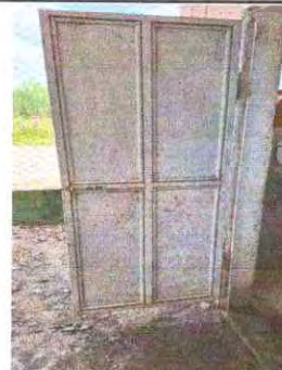
Foto 2: Se observa que es necesario la sustitucion de puerta en el modulo se servicios sanitarios.
