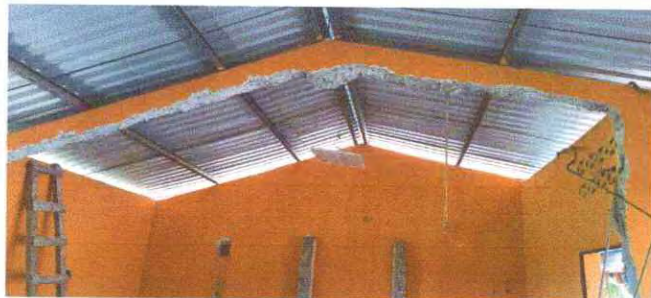
Foto 7: Se observa que es necesario soporte de metal para módulo I.
