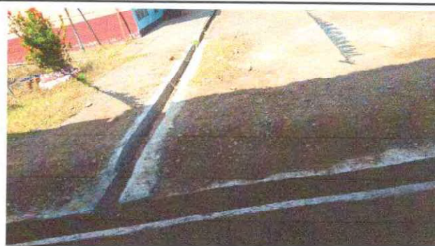
Foto 10: Se observa que es necesario asegurar y darle mantenimiento a cuneta de concreto.
