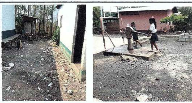
Foto 12: Se observa que el patio exterior necesita conformación de pavimento, debido al polvo y lodo que se genera en el verano e invierno, respectivamente.
