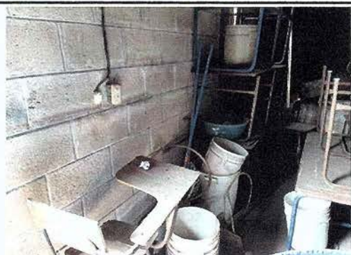
Foto 9: Se observa el área en donde es necesario el suministro de un banco de trabajo de concreto y azulejo
