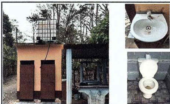
Foto 11: Se observa el deposito de agua en mal estado, es necesario sustituirlo. Asimismo los artefactos sanitarios necesitan mantenimiento correctivo
