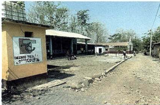
Foto 1: Se observa el ingreso al Centro Educativo
