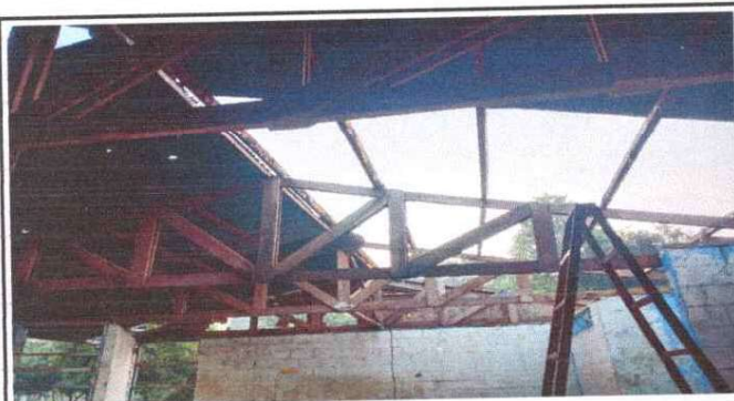
Foto 9: se observa la estructura de madera esta siendo quitado
