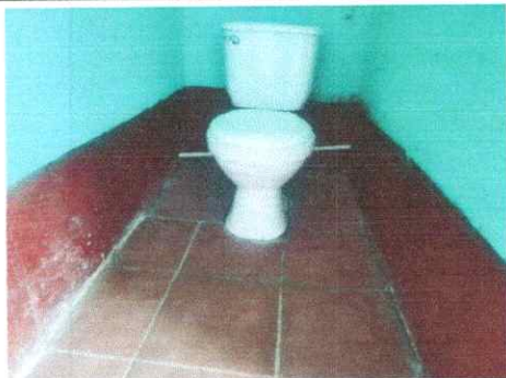
FOTO 7: Suministro e instalación de piso cerámico antidelizante
