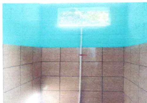
FOTO 10: Reparación de ducha
