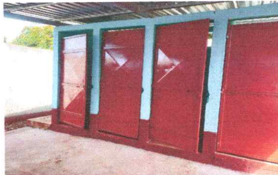
FOTO 8: Mantenimiento de puertas de metal (incluye lijado, cepillado, cambio de tubo y aplicación de pintura anticorrosiva + esmalte)
