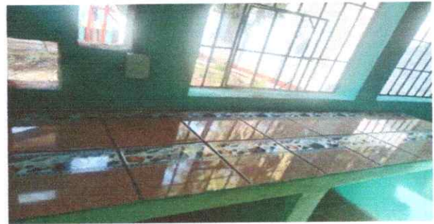
FOTO 16: Suministro e instalación de azulejo
