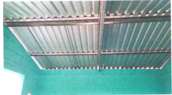
FOTO 14: Sustitución de estructura de soporte de metal (incluye conformación de muro + mojinete)
