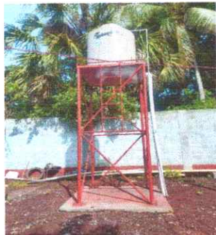
FOTO 25: Sustrucción de depósito de agua (incluye tubería, accesorios, mantenimiento a estructura portante de metal y bases de concreto)
