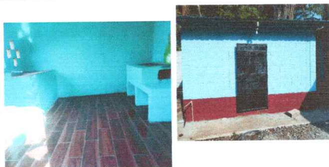
FOTO 24: Resane y aplicación de pintura latex acrílica en muros exteriores e interiores
