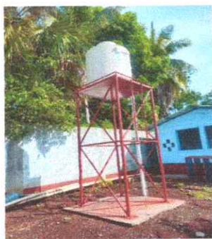
FOTO 25: Sustrucción de depósito de agua (incluye tubería, accesorios, mantenimiento a estructura portante de metal y bases de concreto)
