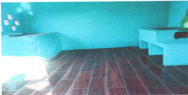
FOTO 17: Suministro e instalación de piso antideslizante
