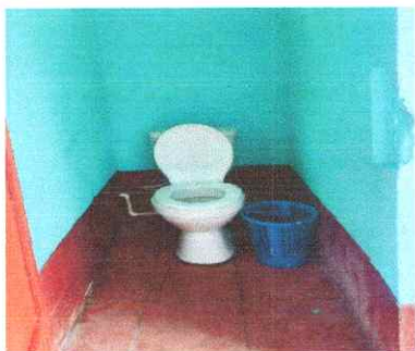
FOTO 5: Reparación de inodoro
