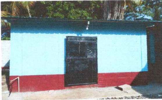
FOTO 13: Sustitución de lámina por lámina troquelada calibre 26 (incluye tornillos, montaje y desmontaje)
