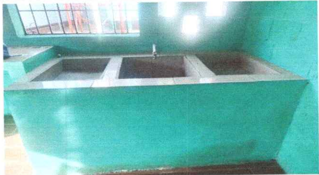
FOTO 19: Sustrucción de pila (incluye base de concreto, instalación hidráulica y sanitaria)
