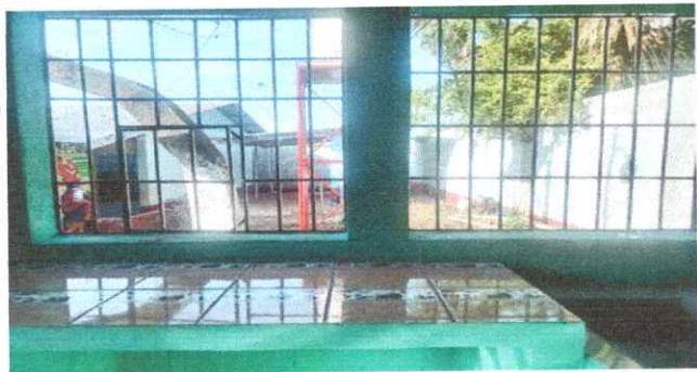
FOTO 21: Conformación de ventana (incluye suministro e instalación de balcón de metal)
