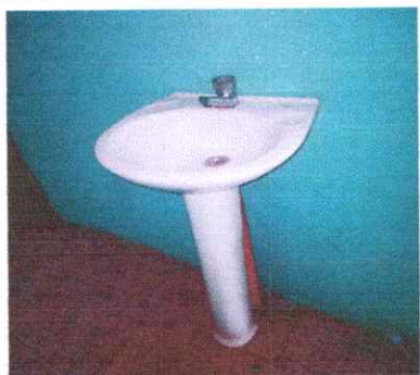
FOTO 9: Reparación de lavamanos
