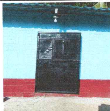
FOTO 22: Mantenimiento de puerta de metal (incluye lijado, cepillado, cambio de tubo y aplicación de pintura anticorrosiva+ esmalte)
