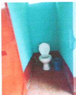
FOTO 11: Resane y aplicación de pintura latex acrílica en muros exteriores e interiores
