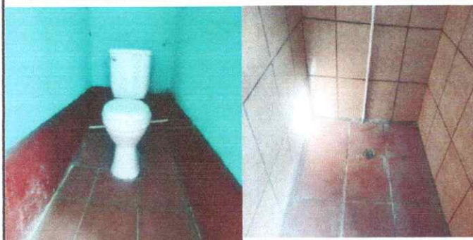
FOTO 6: Suministro e instalación de azulejo
