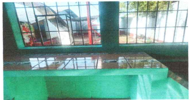
FOTO 18: Suministro e instalación de banco de trabajo de concreto y azulejo
