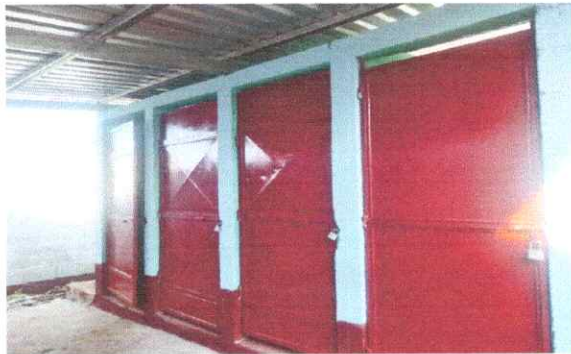
FOTO 1: Sustitución de lámina por lámina troquelada calibre 26 (incluye tornillos, montaje y desmontaje)
