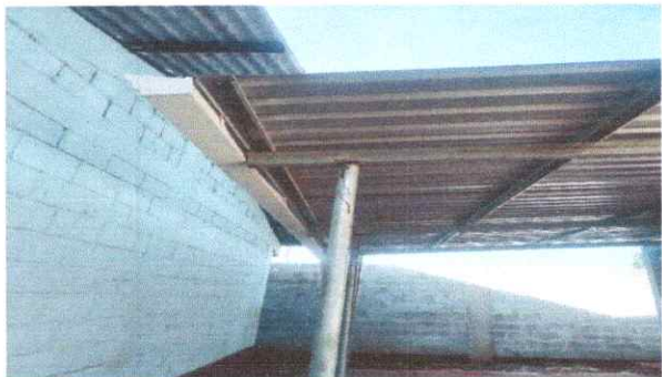
FOTO 3: Suministro e instalación de canal de metal (incluye bajada de agua)
