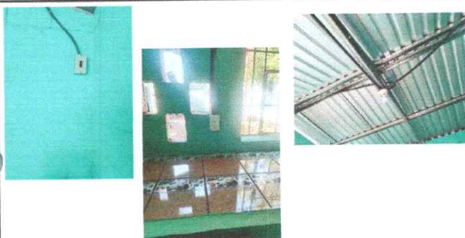
FOTO 23: Suministro e instalación del sistema eléctrico (incluye 2 luminarias, 4 tomacorrientes, 1 apagador y tablero flipones)
