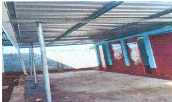
FOTO 2: Sustitución de estructura de soporte de metal (incluye columnas metálicas y base de concreto)
