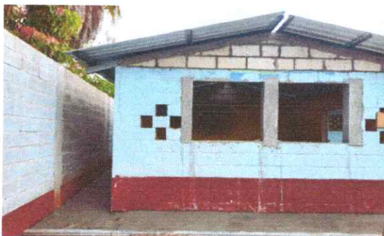
FOTO 15: Conformación de banqueta
