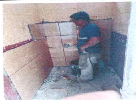
FOTO 6: Suministro e instalación de azulejo
