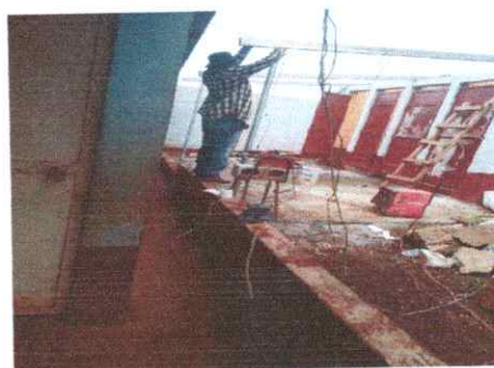
FOTO 2: Sustitución de estructura de soporte de metal (incluye columnas metálicas y base de concreto)
