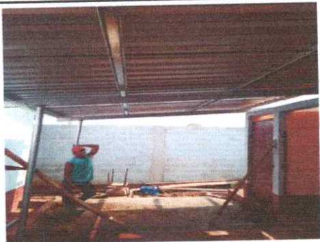
FOTO 1: Sustitución de lámina por lámina troquelada calibre 26 (incluye tornillos, montaje y desmontaje)
