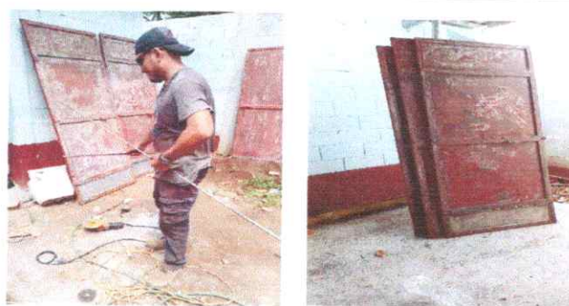
FOTO 8: Mantenimiento de puertas de metal (incluye lijado, cepillado, cambio de tubo y aplicación de pintura anticorrosiva + esmalte)
