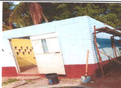
FOTO 22: Mantenimiento de puerta de metal (incluye lijado, cepillado, cambio de tubo y aplicación de pintura anticorrosiva+ esmalte)
