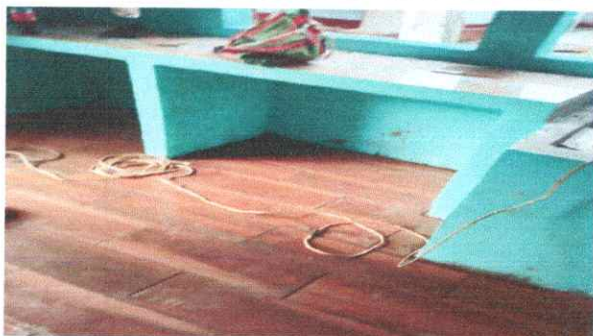
FOTO 17: Suministro e instalación de piso antideslizante
