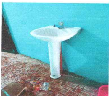
FOTO 9: Reparación de lavamanos
