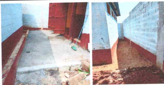
FOTO 4: Reparación de pavimento de concreto (incluye banquetta)
