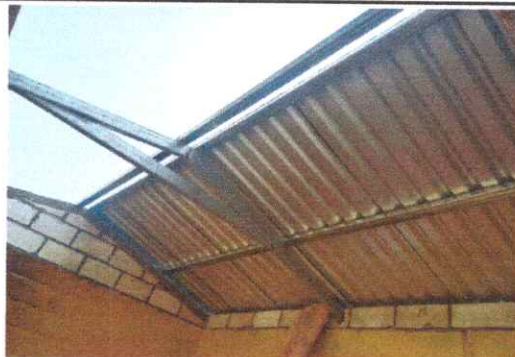
FOTO 14: Sustrucción de estructura de soporte de metal (incluye conformación de muro + mojinete)
