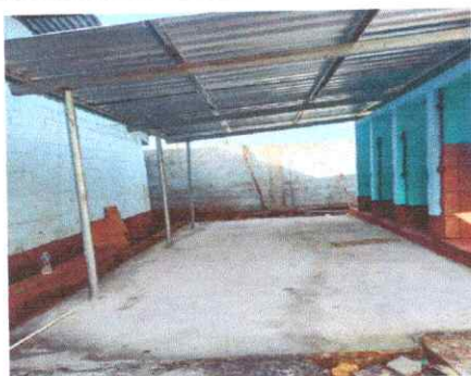
FOTO 3: Suministro e instalación de canal de metal (incluye bajada de agua)
