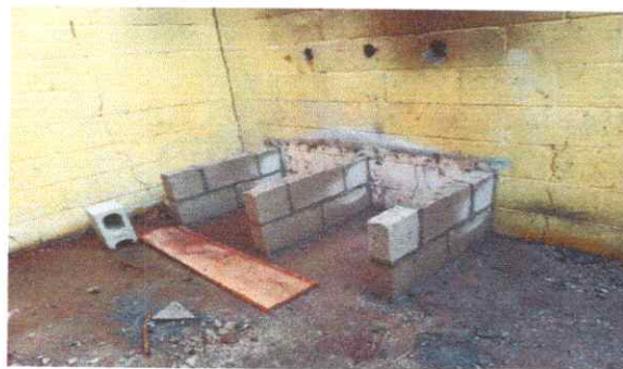
FOTO 20: Sustrucción de estufa rural (incluye extractor de humo)
