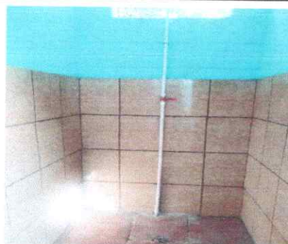
FOTO 10: Reparación de ducha
