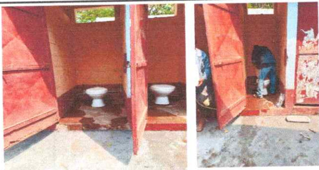
FOTO 5: Reparación de inodoro
