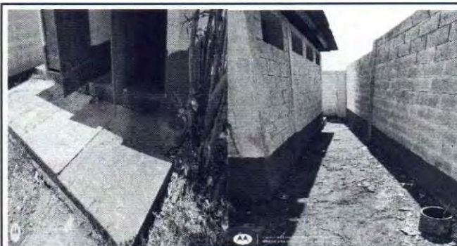
Foto 4: Reparación de pavimento de concreto (incluye banqueta)
