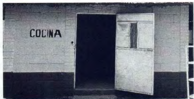
Foto 22: Mantenimiento a puerta de metal (incluye lijado, cepillado, cambio de tubo y aplicación de pintura anticorrosiva + esmalte)
