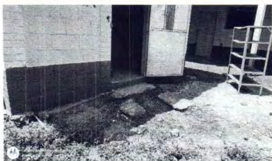
Foto 15: Conformación de banqueta
