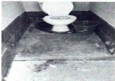
Foto 7: Suministro e instalación de piso cerámico antidelizante
