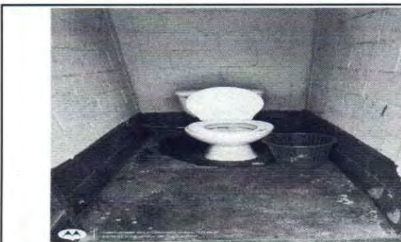
Foto 6: Suministro e instalación de azulejo
