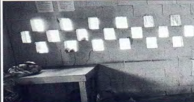
Foto 16: Suministro e instalación de azulejo
