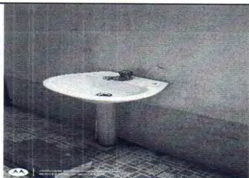
Foto 9: Reparación de lavamanos
