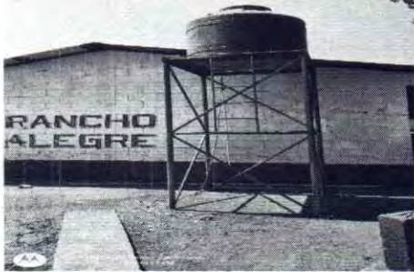
Foto 25: Sustrucción de depósito de agua ( incluye tubería, accesorios, mantenimiento a estructura portante de metal y bases de concreto)
