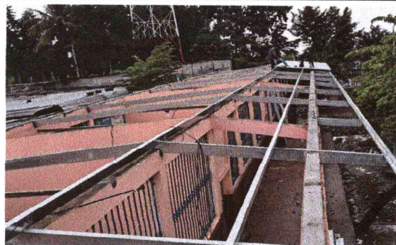
Foto 2: Se observa la instalación de estructura metálica
