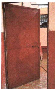
Foto 3: Se observa la sustitución y mantenimiento de puertas
