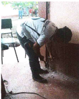
Foto 3: Se observa el mantenimiento y cambio de puertas
