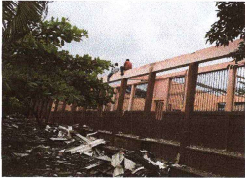
Foto 1: Se observa el desmontaje de la lámina duralita que estaba en mal estado
