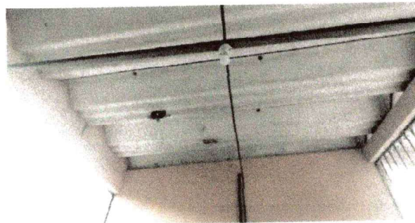
Foto 2: Suministro de Estructura metálica, se observa la necesidad de colocar estructura ya que no tenía la antigua lámina
