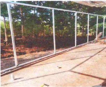
Foto 9: Se observa muro perimetral en proceso de concluir
