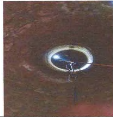
Foto 8: Se observa mantenimiento de pozo e instalacion de bomba en proceso
