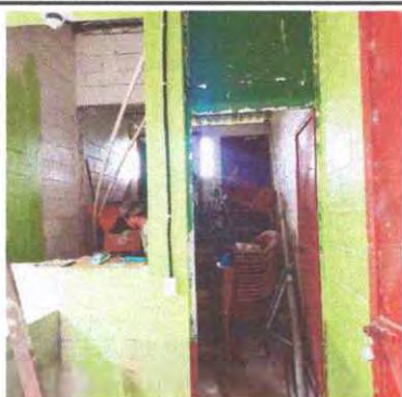
foto 15: Se observa pintada de pared
