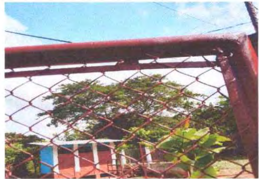
Foto 10: Se observa porton en proceso de remozamiento
