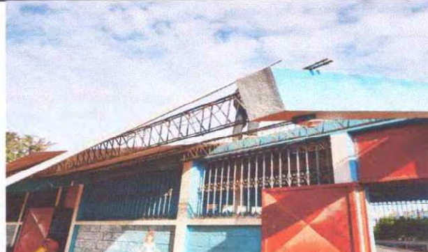
Foto 2: Se observa el cambio de la estructura metalica del techo
