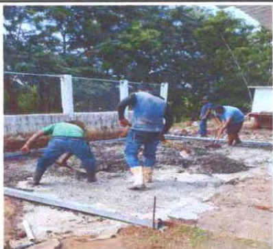
Foto 3: Se observa trabajo de torta de concreto
