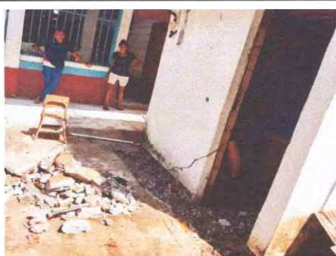
Foto 4: Se observa trabajo para cambio de puerta en area de pozo
