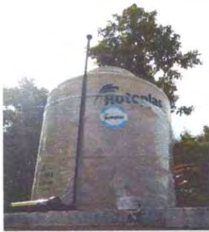
Foto7: Se observa deposito de agua listo para ser instalado
