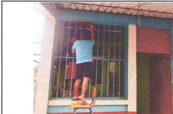
Foto13: Se observa mantenimiento a balcon de metal
