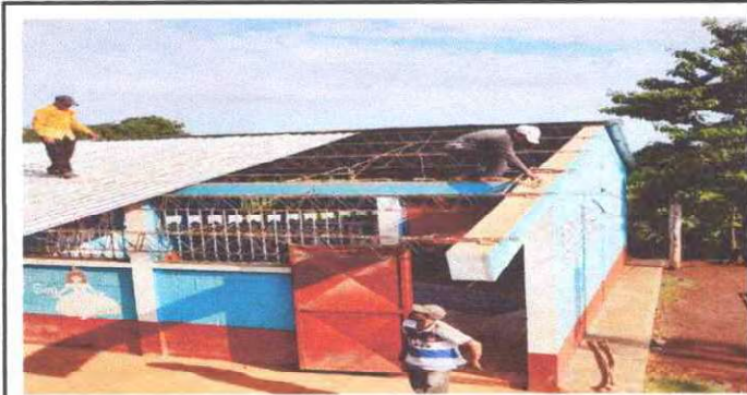
Foto1: Se observa cambio de techo que estaba en mal estado
