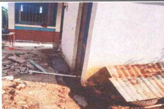
Foto 5: Se observa sanjeo del area donde pasara la tuberia principal
