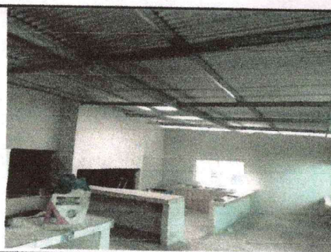
Foto 6: Se realizó cambio de estructura metálica y lámina.
