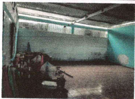
Foto 1: Se observa que el aula tiene piso nuevo.
