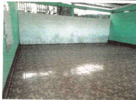
Foto 2: Se observa que la pared fue repellada y cernida.
