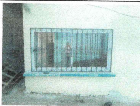
Foto 5: Se instalo ventana nueva a la cocina.
