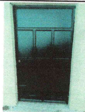
Foto 4: Puerta de la cocina fue reparada.
