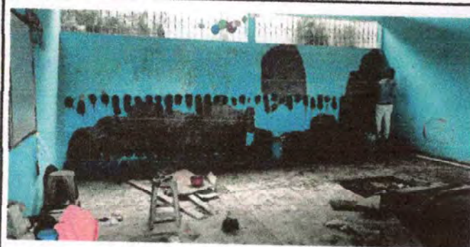
Foto 4: Avanzando en los trabajos de las paredes.
