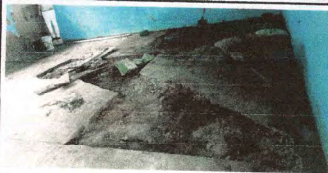
Foto 1: Iniciando los trabajos de reparación de piso.
