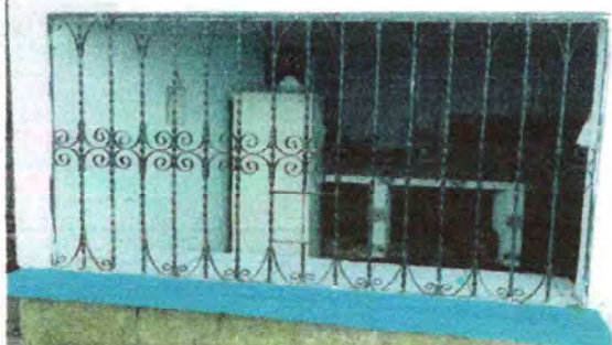
Foto 5: La cocina necesita ventana.
