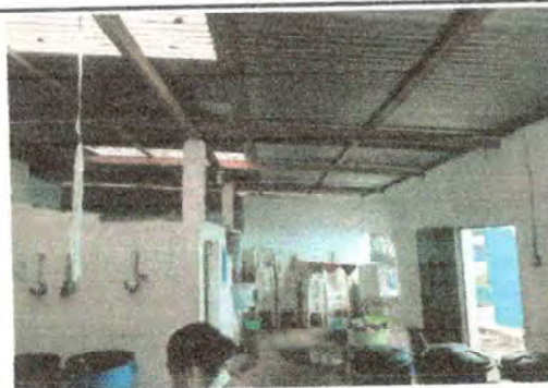
Foto 6: La lámina de metal y estructura de soporte de madera en muy mal estado.
