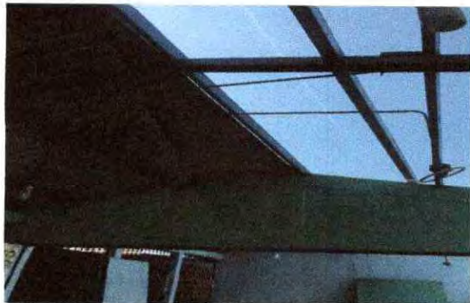
Foto 1: Se observa el cambio de lámina de aluzinc
