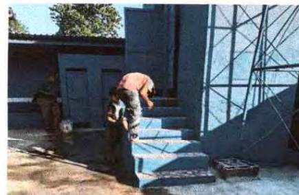
Foto 12: Se observa la reparacion de las gradas
