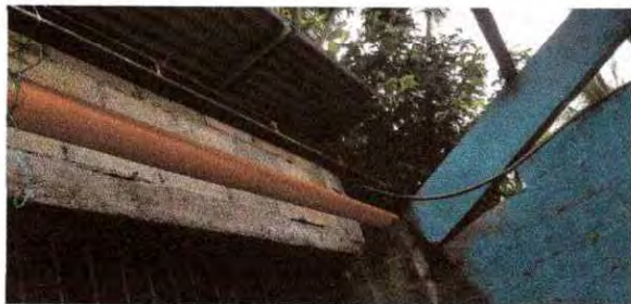
Foto 5: Se oobserva el proceso de sustitucion de canal de pvc
