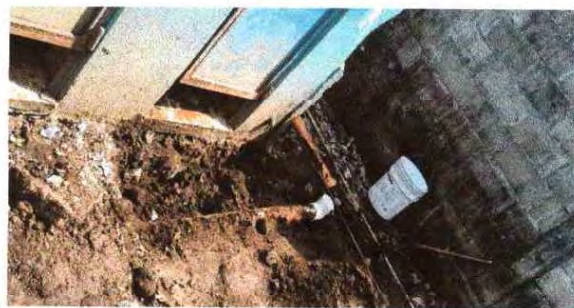
Foto 10: Se observa el cambio de la tubería principal
