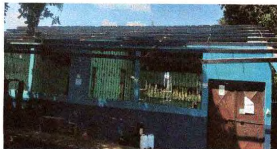
Foto 2: Se observa el mantenimiento de la estructura
