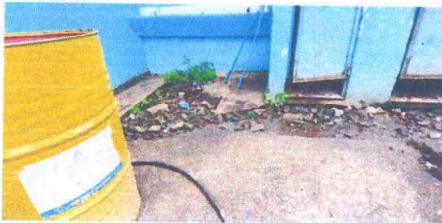
Foto 7: Se observa en mal estado la torta de cemento de acceso a los sanitarios
