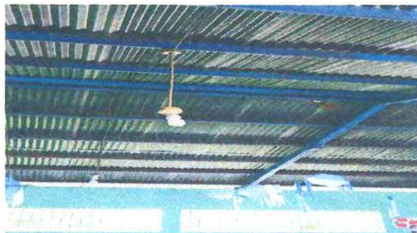
Foto 1: Se observa que la lámina de zinc, se encuentra en mal estado con varios agujeros
