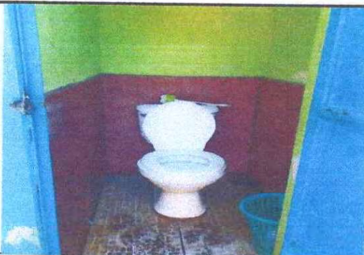
Foto 11: Mantenimiento de servicios sanitario y accesorios
