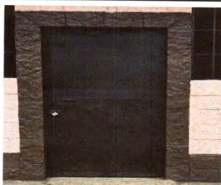
Foto 9: Se dio mantenimiento a puerta de cocina
