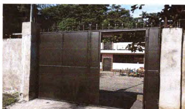
Foto 14: Se observa el cambio del porton
