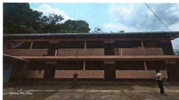
Foto 2: Se aplico pintura a los muros de interiores y exteriores de modulo
