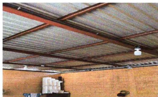
Foto 4: Sustitucion de sistema electrico modulo II
