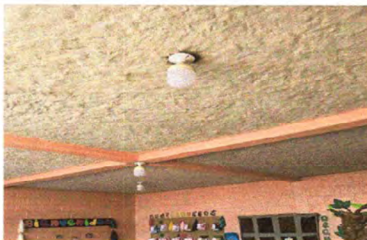
Foto 1: se observa la instalacion del sistema electrico modulo I
