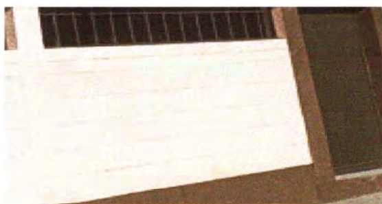
Foto 5: Pintura a paredes de cocina
