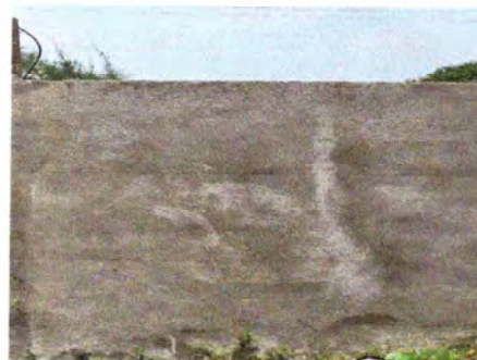
Foto 10: Se repello el muro perimetral
