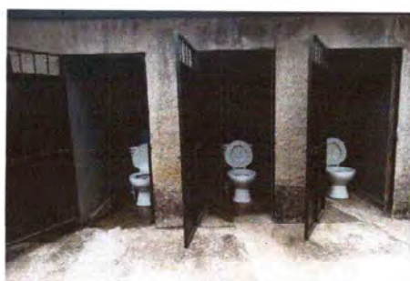
Foto 11: Se repello paredes de sanitarios y migitorios
