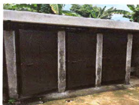
Foto:12 Se sustituyeron puertas en los sanitarios
