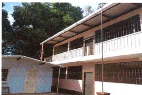
Foto 15: Se instala canal de metal ya no perjudicará al aula
