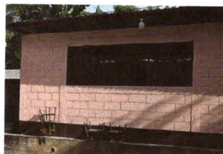
Foto 8: Se aplico pintura a la cocina
