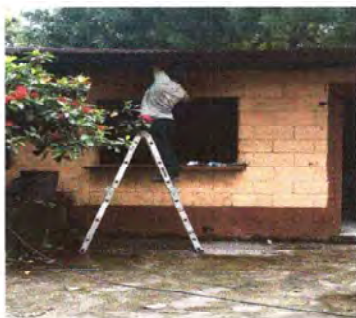
Foto 5: Avance aplicación de pintura a paredes de cocina
