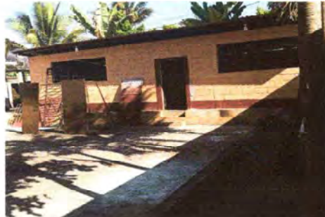
Foto 6: Avance al amntenimiento de puerta del salón
