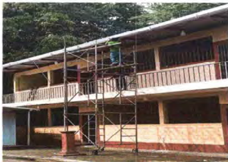
Foto 15: Se observa el avance del cambio de canal
