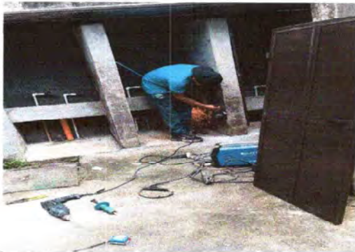
Foto 13: Se observa el avance de cambio de puertas migitorios
