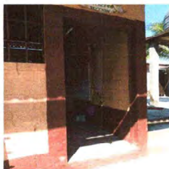
Foto 3: Se observa el desmontaje de puertas para mantenimiento
