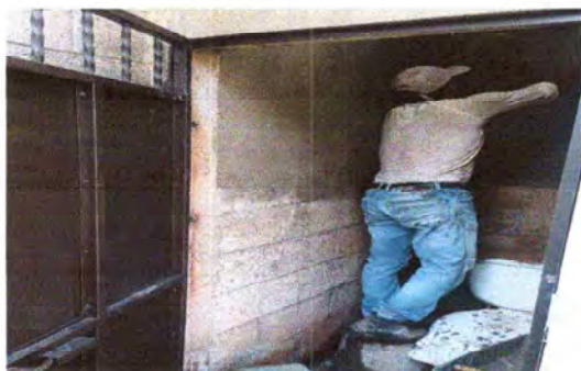
Foto 11: Se observa el avance realizado en el repello de los sanitarios y migitorios
