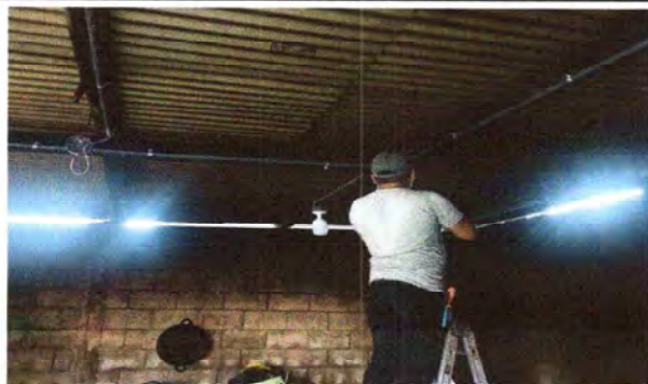
Foto 7: Se observa el avance en el cambio de sistema electrico en modulo de cocina
