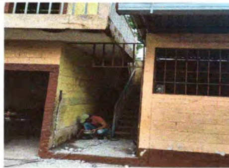
Foto 2: Se observa el avance de la aplicación de pintura de modulo I
