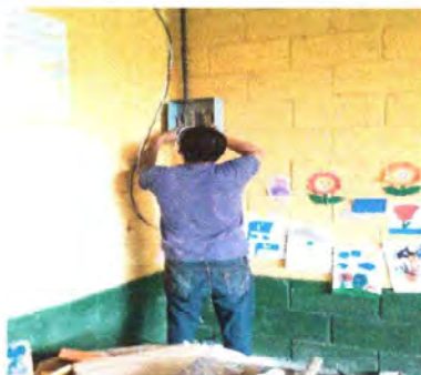
Foto 1: Se observa avance del cambio del sistema electrico modulo I
