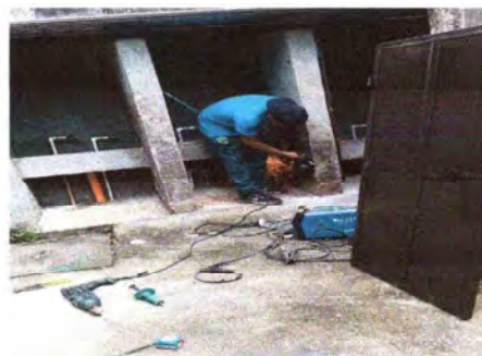
Foto 12: Se observa el avance en la sustitucion de puertas de sanitarios
