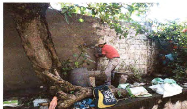
Foto 10: Se observa el avance en el repello del muro perimetral
