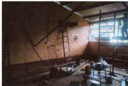
Foto 4: Avance de sustitucion del sistema electrico modulo II
