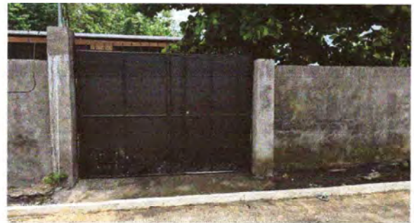
Foto 14: Se observa el avance de cambio de portón
