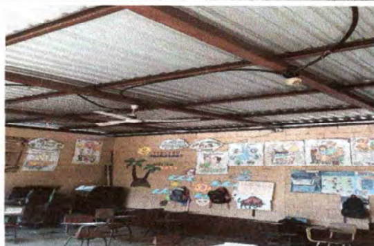
Foto 4: Sustitucion de sistema electrico modulo II
