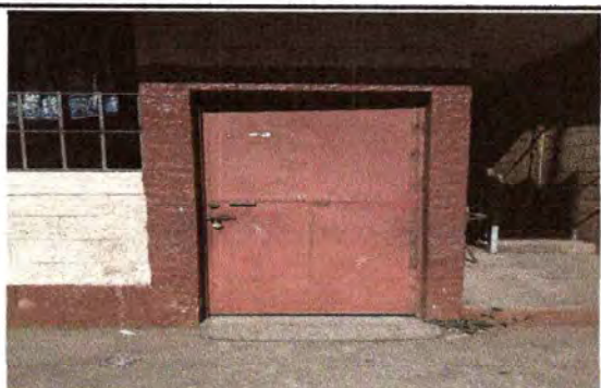
Foto 3: Mantenimiento de puerta a puerta de aulas
