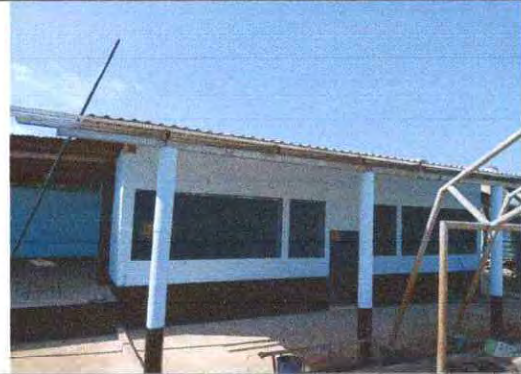
Foto 2: Se observa que las laminas del modulo I, se sustituyeron por completo.
