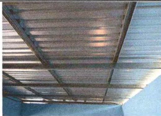
Foto 3: Se observa que la estructura de soporte de madera ya no existe porque fue sustituida por soporte de metal.
