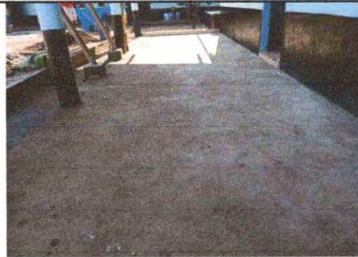
Foto 8: Se observa que se aplicó la torta de concreto en area exterior del modulo I
