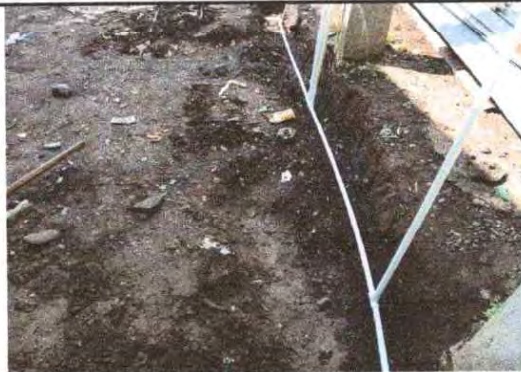
Foto 14: Se observa que la tubería principal, se sustituyó completamente.
