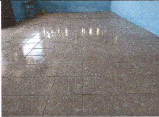
Foto 1: Se observa que el piso del módulo 1, se sustituyó por piso cerámico.
