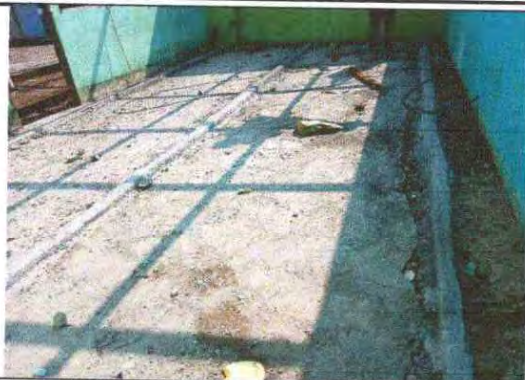
Foto 1: Se observa que el piso se está sustituyendo por piso ceramico del modulo I
