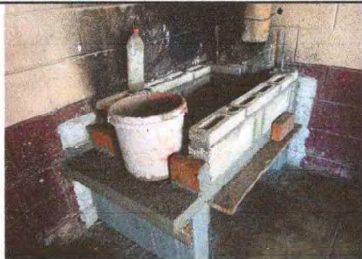
Foto 13: Se observa que la estufa rural se está construyendo de nuevo.
