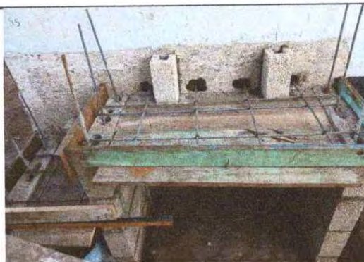
Foto 10: Se observa que las estaciones de lavado en los sanitarios para uso de los niños se están construyendo.
