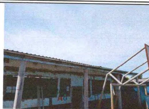
Foto 2: Se observa que las laminas del modulo 1, se están sustituyendo.
