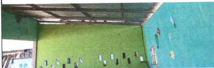
Foto 7: Se observa que en el aula, las paredes ya están listas para la aplicación de pintura.
