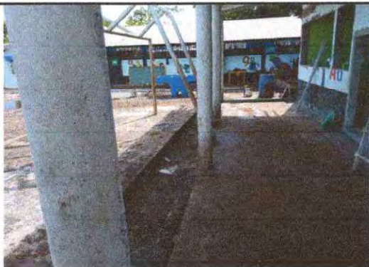
Foto 15: Se observa que las columnas se están reparando.
