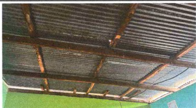
Foto 3: Se observa que la estructura de soporte de madera es necesario su sustitucion por metal.
