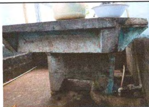
Foto 12: Se observa que es necesario sustituir la pila de cemento de dos lavaderos.
