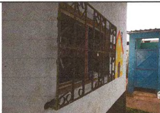
Foto 5: Se observa que los balcones es necesario sustituirlos
