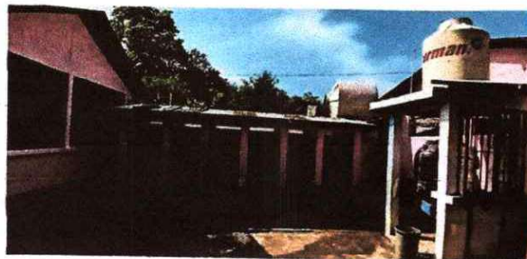
Foto 10: Se observa el mal estado de la pintura
