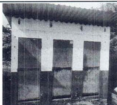
FOTO 6: SE OBSERVA EL ÓXIDO Y DETERIORO EN LAS PUERTAS, URGE CAMBIO.
