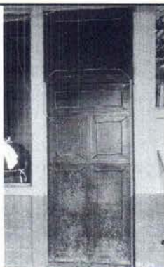
FOTO 3: SE OBSERVA EL ÓXIDO EN LAS PUERTAS, URGE MANTENIMIENTO.
