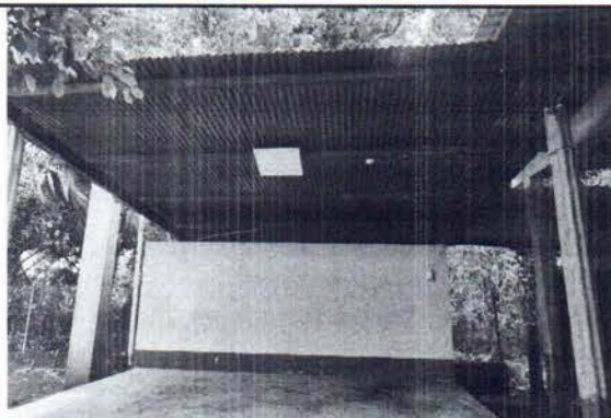
FOTO 1: SE OBSERVA EN EL ESCENARIO EL DETERIORO DE LÁMINAS Y EL ÓXIDO DE LA ESTRUCTURA DE SOPORTE, URGE SUSTITUCIÓN.
