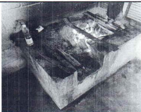
FOTO 2: SE OBSERVA EL MAL ESTADO DE LA ESTUFA RURAL Y QUE NO CUENTA CON LA PLANCHA DE METAL COMPLETA.
