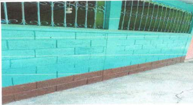
FOTO 19: Finalización de pintado en muro exterior e interior en aula.
