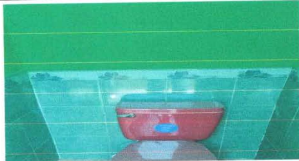
FOTO 10: Finalización de resane y pintura.
