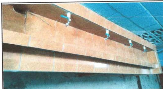
FOTO 12: Finalización de reparación de estación de lavado de concreto y azulejo, grifos y accesorios.
