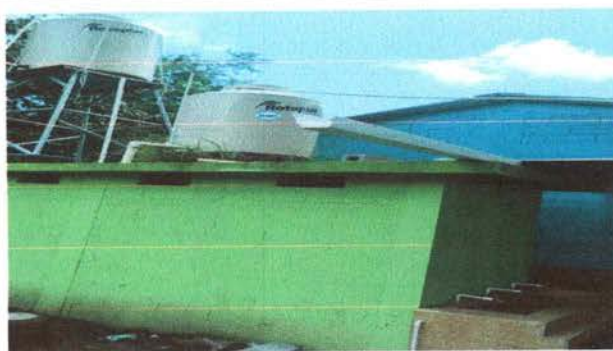
FOTO 14: Finalización de instalación de depósito de agua.
