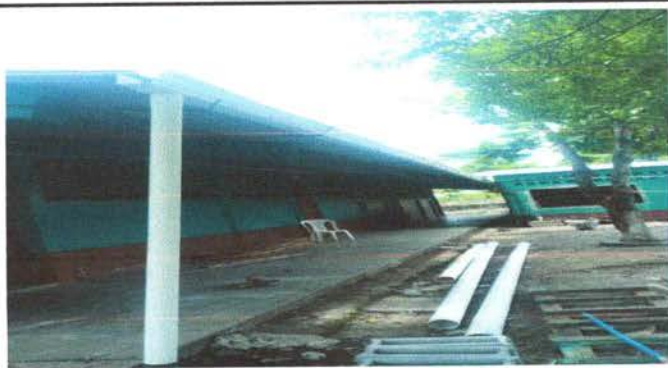
FOTO 15: Finalización de sustitución de Canal por PVC
