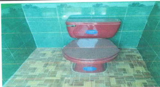
FOTO 9: Finalización de instalación de azulejo.
