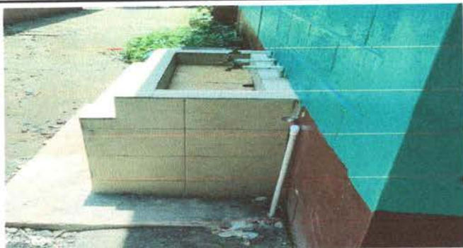
FOTO 13: Finalizar de instalación de estación de concreto y azulejo.
