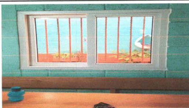
FOTO 18: Finalización de sustitución de estructura de aluminio
