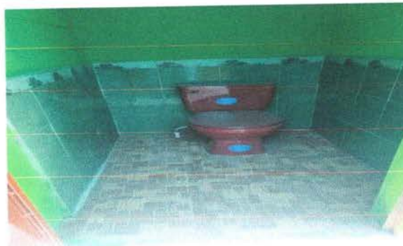
FOTO 8: Finalización de suministro de sustitución de inodoros.
