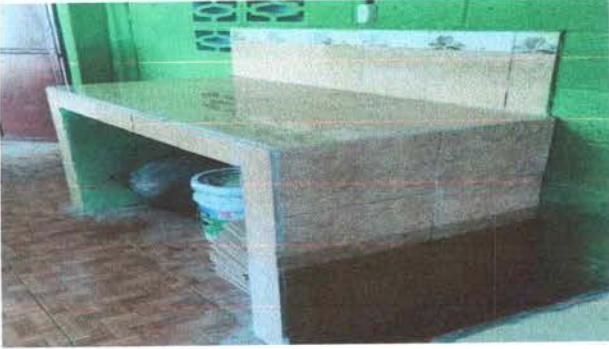
FOTO 1: Finalización de conformación de trabajo de concreto.
