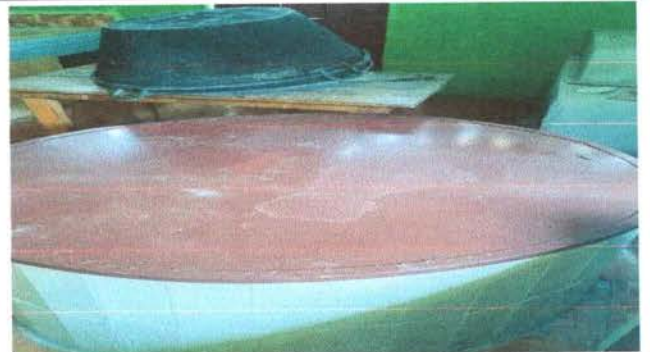
FOTO 6: Finalización de instalación de tapadera de metal en pozo de agua.
