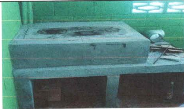
FOTO 3: Finalización de colocación de colchon por estufa rural.
