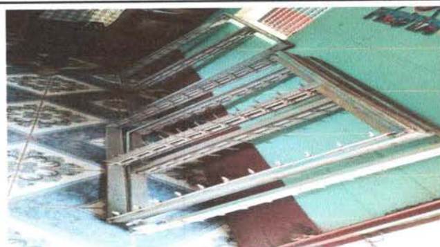
FOTO 18: Proceso de sustitución de estructura de aluminio por PVC-
