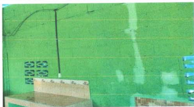
FOTO 5: Proceso de aplicación pintura latex en muro exterior e interior.
