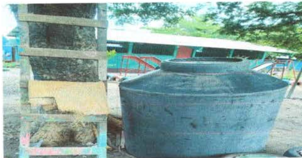
FOTO 14: Proceso de instalación de depósito de agua.
