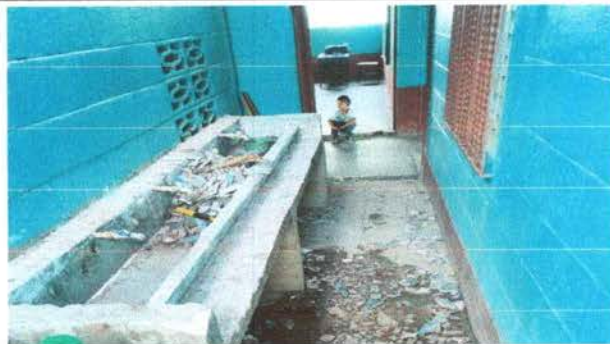
FOTO 12: Proceso de reparación de estación de lavado de concreto.
