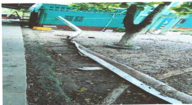
FOTO 15: Proceso de sustitución de canal por PVC.
