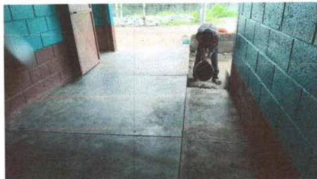
FOTO 16: Proceso de sustitución de piso de torta de concreto.
