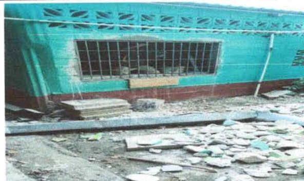
FOTO 4: Proceso de instalación de ventanas.
