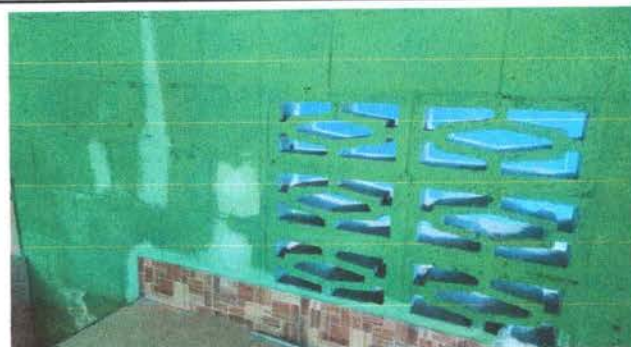
FOTO 2: Proceso de instalación de azulejo en muro.
