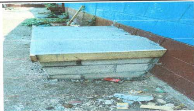
FOTO 13: Proceso de instalación de estación de concreto y azulejo.
