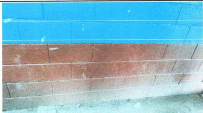
FOTO 19: Proceso de pintado en muros exterior e interiores en aula.
