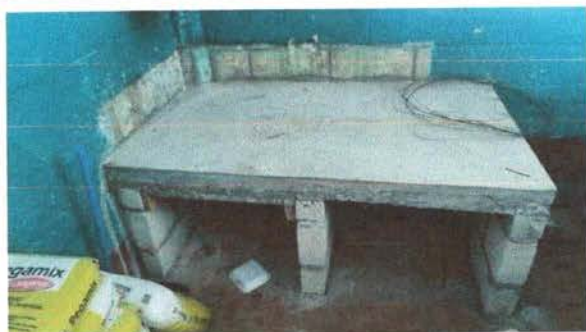
FOTO 3: Proceso de colocación de polietileno por estufa rural.
