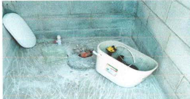
FOTO 8: Proceso de sustitución de inodoro.
