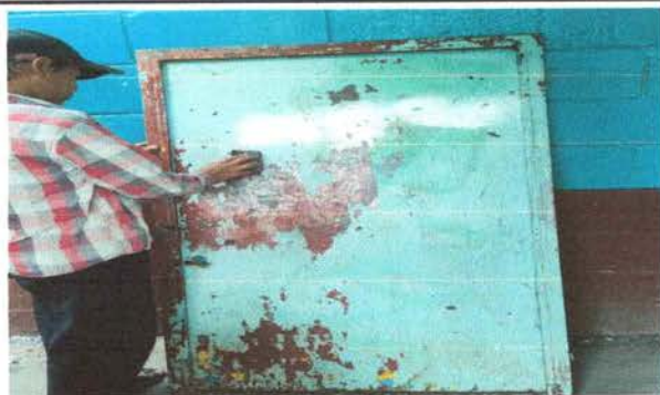
FOTO 11: Proceso de mantenimiento de puerta de metal.
