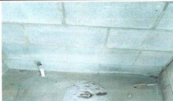
FOTO 9: Proceso de instalación de azulejo.
