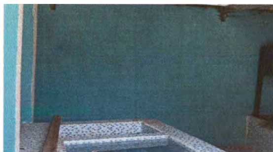
Foto 5: Se observa que falta repello en paredes de la cocina
