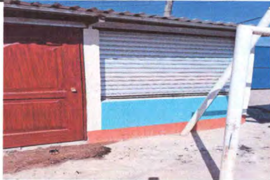
Foto 8: Se observa la mejora con la instalación de ventana
