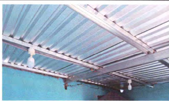
Foto 10: Se observa la mejora con el cambio de lamina
