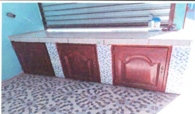
Foto 7: Se observa la mejora en gabinete.
