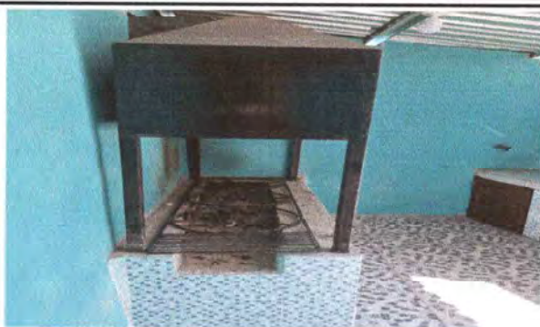
Foto 1: Se observa el mal estado de la estufa rural
