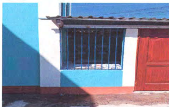
Foto 9: Se observa la mejora con la instalación del balcón
