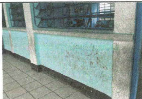
Foto 18: Se observa el mal estado de la pintura en módulos
