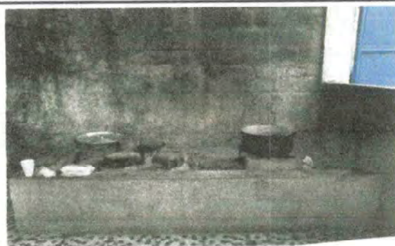
Foto 3: Se observar que falta extractor de humo
