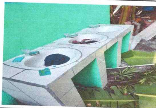
Foto 16: Se observa como quedaron los lavamanos
