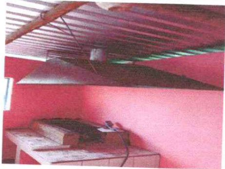
Foto 13: Se observa que ya se ha colocado la chimenea para evitar el deterioro de la lámina
