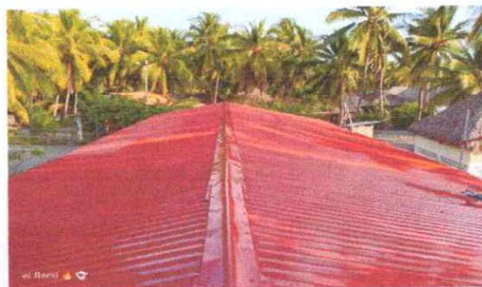
Foto 4: Se observa que algunas láminas de zinc MÓDULO 2, se le dio mantenimiento.
