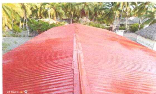
Foto 3: Se observa que la lámina del MÓDULO 2, se encuentra terminado el mantenimiento que se le dio.
