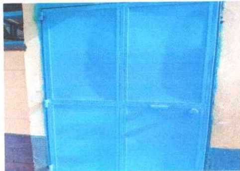
Foto 2: Se observa que las puertas del MÓDULO 1, está terminado el mantenimiento y aplicada la pintura
