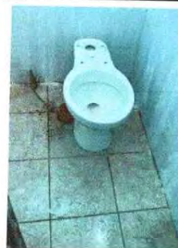
Foto 4: SUSTITUCIÓN DE INODORO (Incluye instalación hidráulica y sanitaria): Se observa que el inodoro se encuentra en mal estado.
