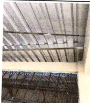
Foto 10: Sustitución de lámina, por lámina troquelada aluzinc calibre 26 (incluye capote, tornillo, desmontaje y montaje): Se observa que las láminas ya tienen agujeros.
