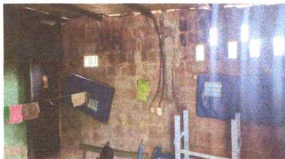
Foto 1: Reparación de muro perimetral, se observa que el muro tiene altura baja.
