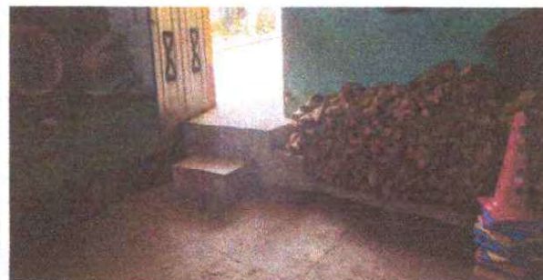
Foto 4: Sustitución de piso torta de concreto se necesita alcanzar una altura adecuada y esta en malas condiciones.
