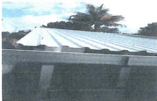
Foto 3: Sustitucion de estructuras de metalica y lamina troquelada
