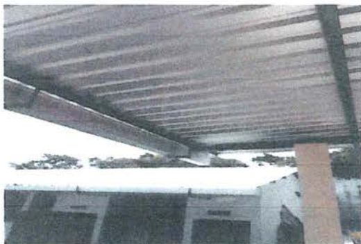
Foto1: Suministro de canales
