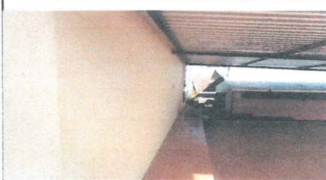
Foto 2: Reparacion de muro perimetral
