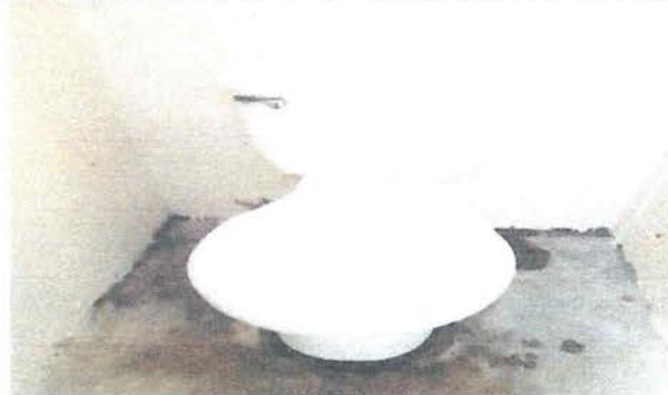
Foto 4: Reparacion de inodoro
