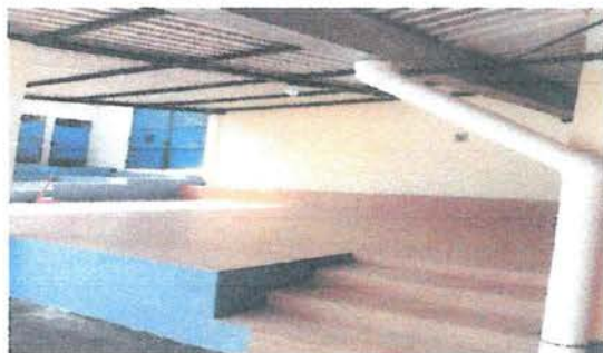
Foto 5: Suministro de estructura metalica y lamina troquelada
