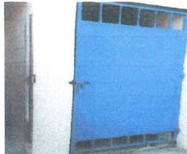
Foto 6: Sustitucion de puerta en servicio Sanitario
