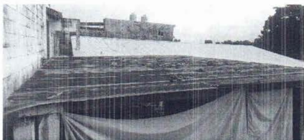
SE NECESITA SUSTITUIR LA LAMINA POR LAMINA TROQUELADA
